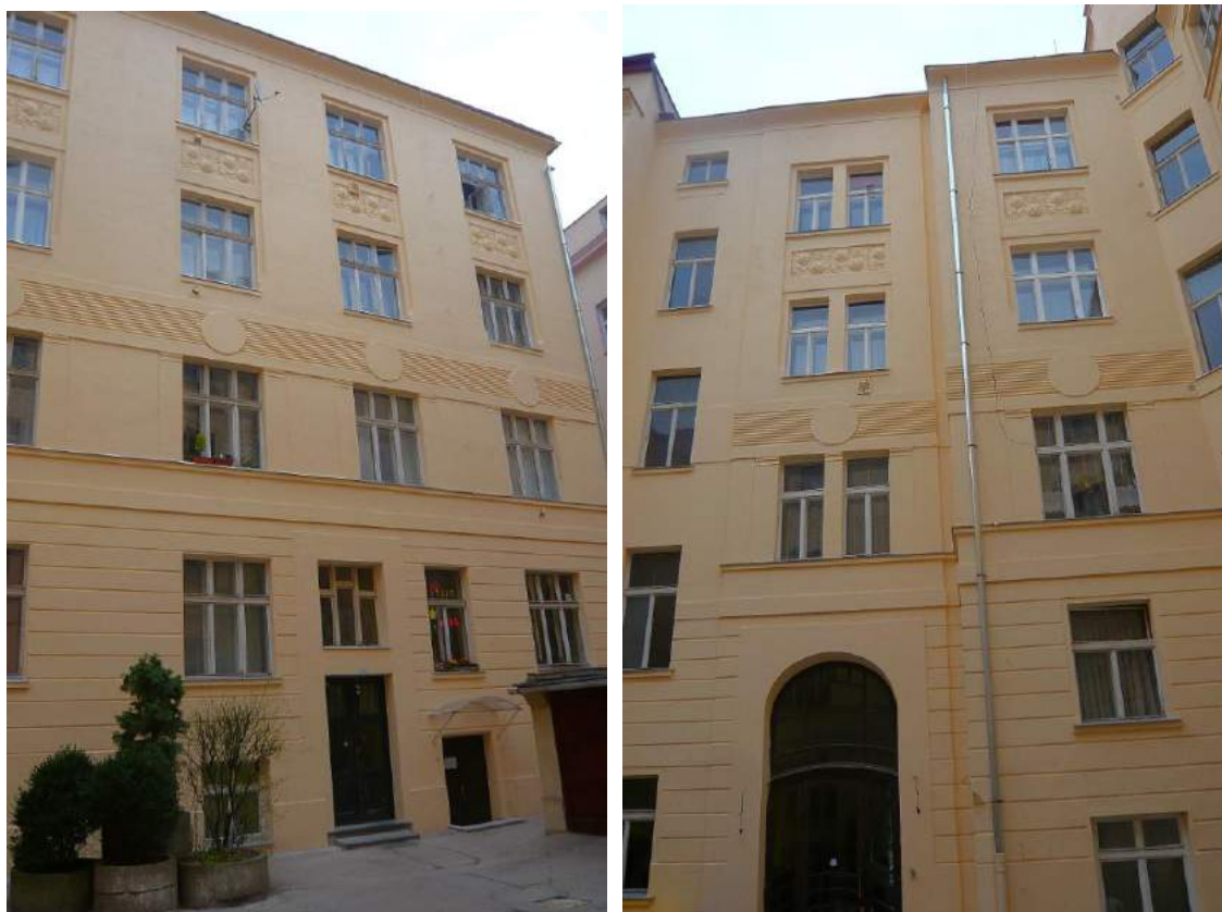
Objekt: dvorní fasáda bytového domu Mikulandská 4, Praha 1 Objednatel: SVJ Mikulandská 4, Praha 1
