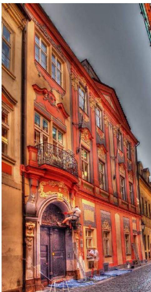
Objekt: Jilská 16, Praha 1 Objednatel: soukromý subjekt
